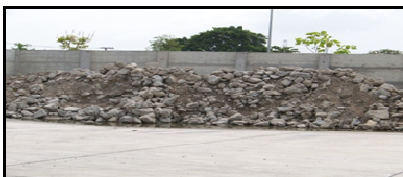
มูลฝอยจากการก่อสร้างและรถขนส่งก่อสร้างนำเข้าสู่โรงงานฯ
