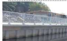
สร้างเขื่อนระบายน้ำ
